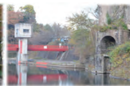
写真5：那須疎水旧取水施設
