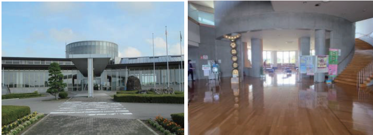
写真1 湯津上庁舎外観
