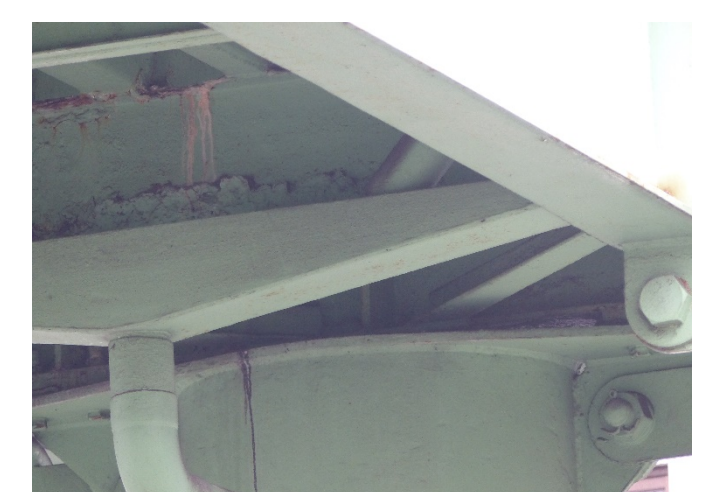
⑥支承付近の腐食
