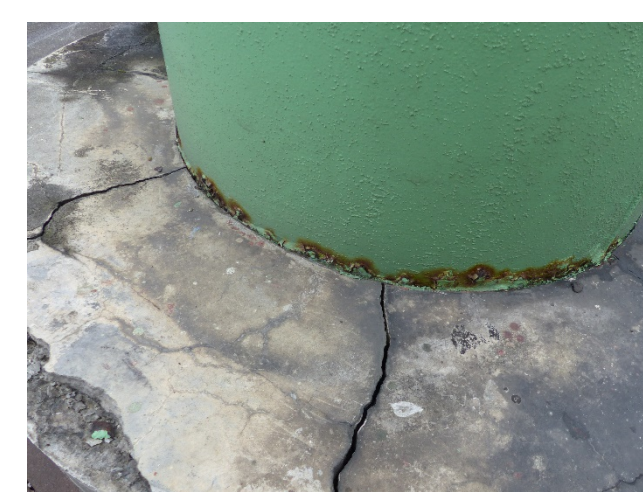
⑤橋脚の腐食
