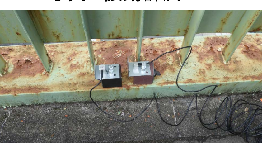
写真3.加速度計設置状況
