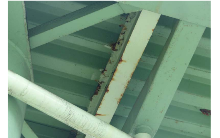
③横構の腐食2
