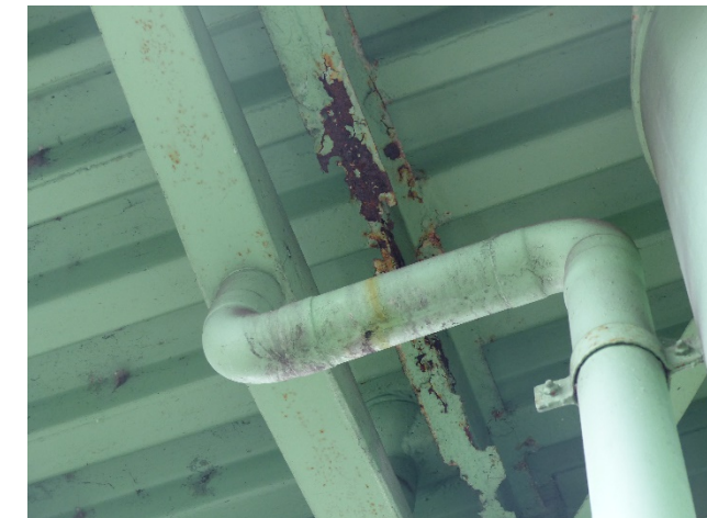
②横構の腐食1
