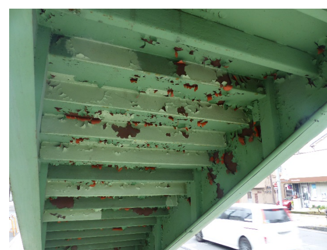
④塗装の剥がれ
