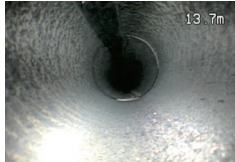
付着物により汚れた水道管内
